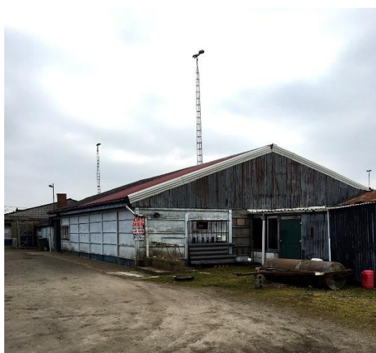
Figuur 13 kantine K.S.V. Drieslinter (2)
