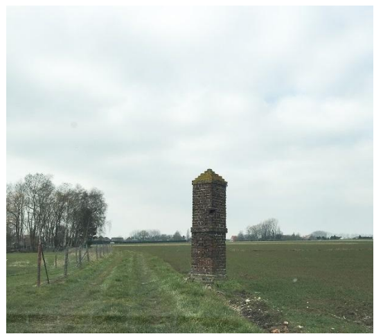
Figuur 21 Onverharde toegang vanuit Molenweg (9)
